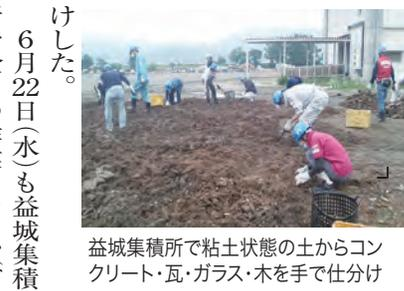
益城集積所で粘土状態の土からコンクリート・瓦・ガラス・木を手で仕分け
